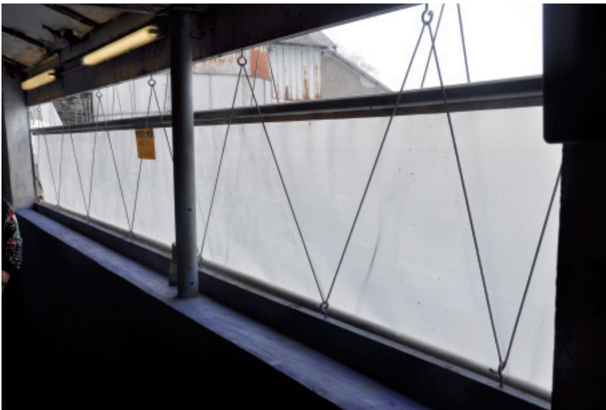
La stabulation entravée rénovée a été équipée avec rideau ouvrable
